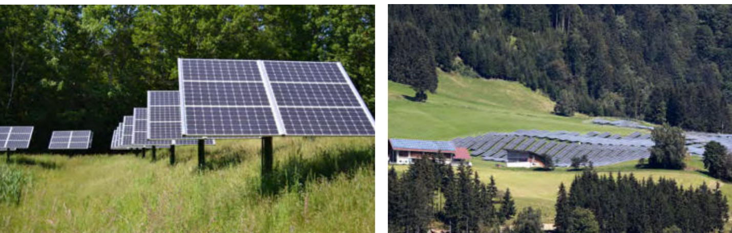
PV-Trakker und PV-Freifläche im Grünland
