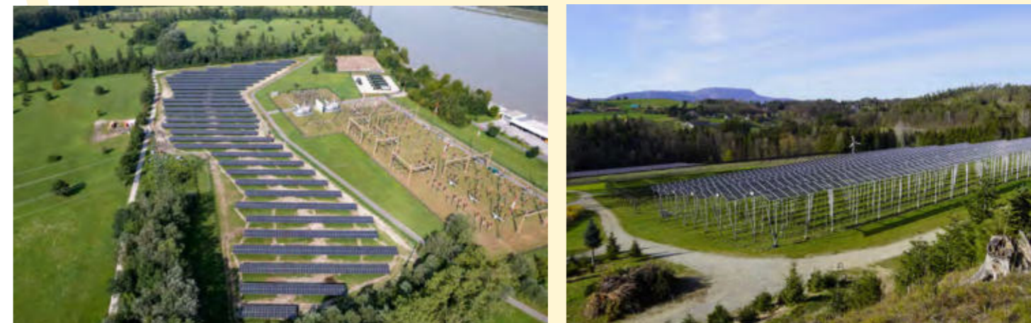
links: PV-Freiflächenanlage des VERBUND beim Kraftwerk Wallsee Mitterkirchen (3 ha, 1,7 MWp) rechts: PV-Freiflächen-Anlage im Obstbau in Nähe Graz
