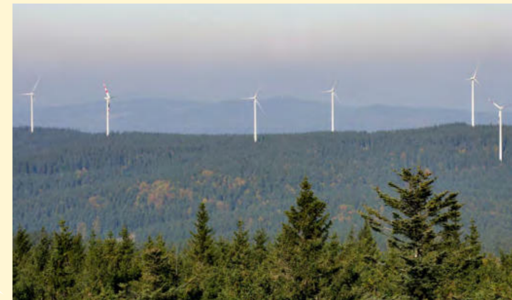
Windpark Sternwind in Vorderweißbach
