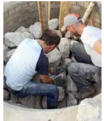
Das Befüllen des Brennofens erfolgt in gewölbeartiger Weise.
