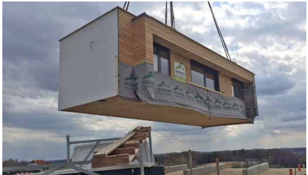
Fix und fertig – inklusive der Fenster – wurden die Ferienhäuser im Buchner-Werk in Möttas zusammengebaut und mit mehreren Tiefladern unter Begleitung von neun Sicherheitsfahrzeugen in die Steiermark gebracht.
