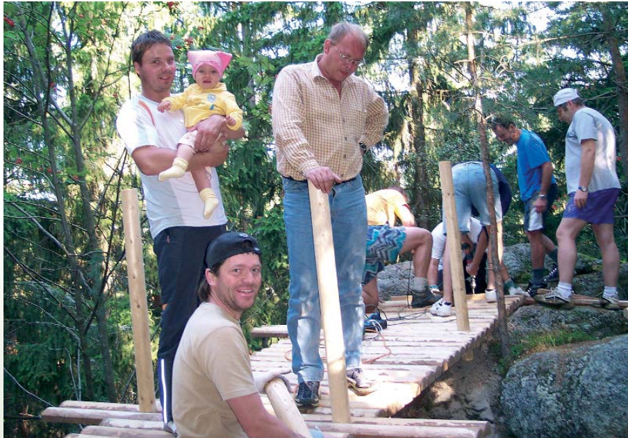
Tatkräftig angepackt wurde beim Bau der Brücke am Mühlberg in St. Leonhard.
