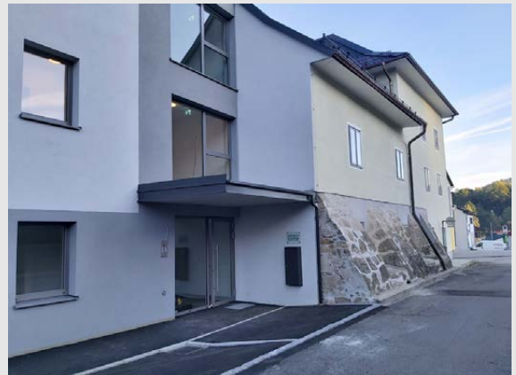
Das ehemalige Gerichtsgebäude neu saniert
